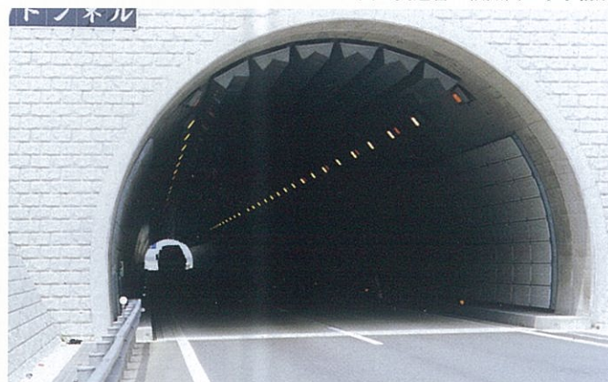
国土交通省 姫路工事事務所 福田トンネル
