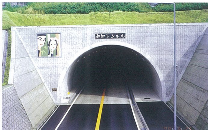
国土交通省 福知山工事事務所
