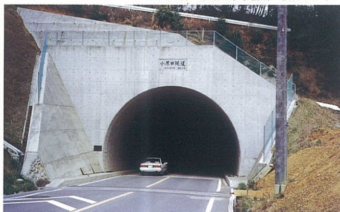
和歌山県農林事務所 小原田トンネル
