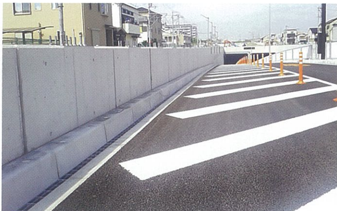
大阪府茨木土木事務所
