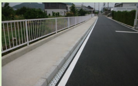
高さ制限のある 張り出し歩道
