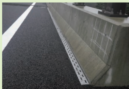
高さ制限のある 道路
